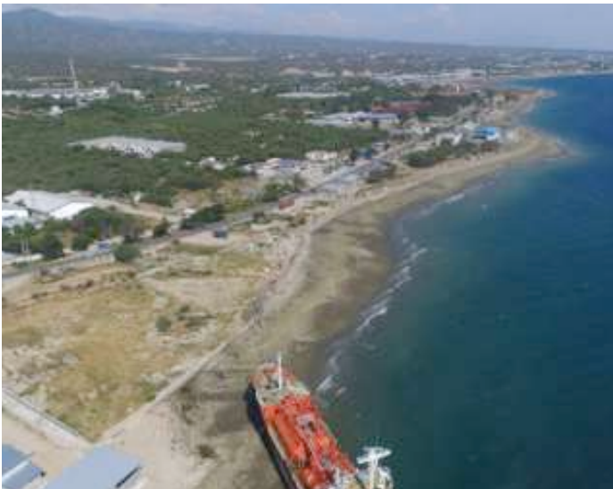
SAMPING DERMAGA LPG PERTAMINA. TERLIHAT BEBERAPA POHON MANGROVE JENIS SONNERTIA ALBA YANG SUDAH MENGERING AKIBAT SISTEM PERAKARANNYA YANG TERGANGGU SETELAH TSUNAMI
